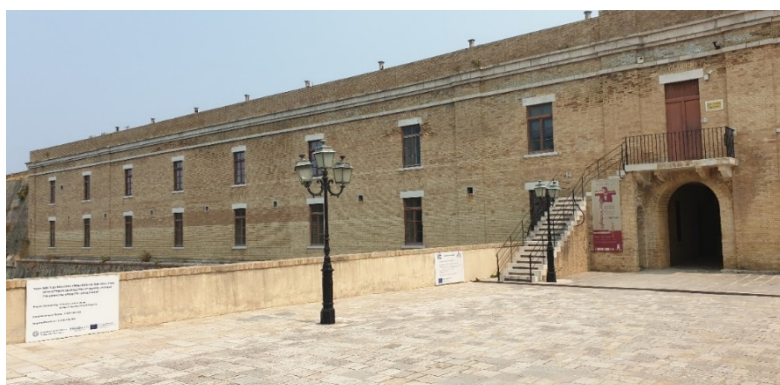
Το κτήριο των Γενικών Αρχείων του Κράτους στην Κέρκυρα (ΓΑΚ-Αρχεία Νομού Κέρκυρας)
